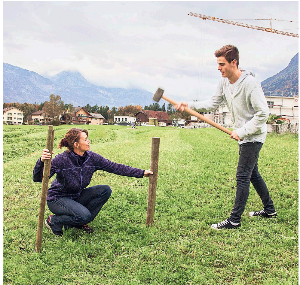
Vereinsbaustelle: Die richtigen Pflöcke sind noch zu setzen.
